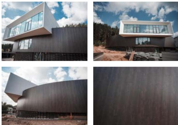
**N**eolith (Iron Moss) - широкоформатная керамика, современный материал из категории керамогранитов, произведенный путем спекания при высокой температуре (более 1200 градусов) смеси кварцевого песка, пигментов и включений. Благодаря таким компонентам и технологии производства, материал ТМ Neolith имеет уникальные физико-механические свойства: не впитывает влагу, устойчив к высоким температурам и ультрафиолетовому излучению, не выцветает.
